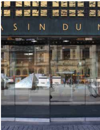
16. Ren glasdør. En gående dørramme, der er udformet helt i glas. Almindelig i nyere byggeri fra sidste halvdel af 1900-tallet.
