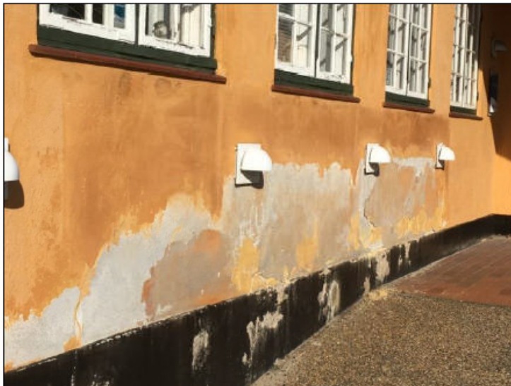
Dårligt murværk med opstigende grundfugt
